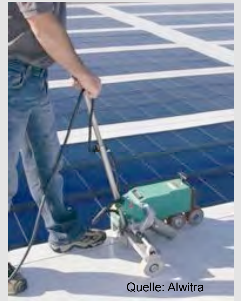
Dachbahn auf Basis EVA-PVC mit integrierten Dünnschichtmodulen: Hochwertige Flachdachabdichtung und Energiegewinnung in einem
